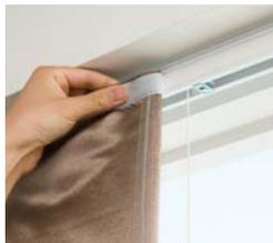
このとき、生地裏面のリングテープの位置と昇降コードの位置を合わせるように取付けてください。
